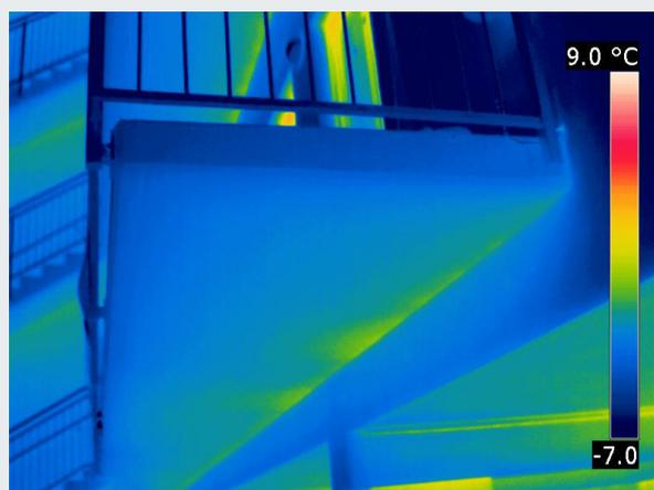
Günstige Temperaturverteilung bei Anordnung von Thermokörben TK. Geringe Wärmeweiterleitung und Vermeidung von Schimmelpilzbildung.
