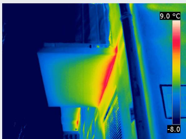
Ohne thermische Trennung großer Wärmeverlust im Übergangsbereich innen-außen. Kälteeinleitung in den Wohnbereich.
